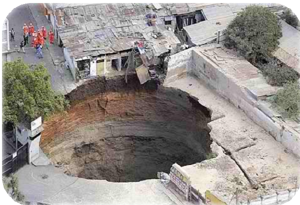
Fig. 1 – Città del Guatemala - Sinkhole 2007
