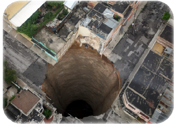
Fig. 2 – Città del Guatemala – Sinkhole 2010
